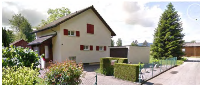
Lärmschutzwand an Kantonsstrasse (wird im Modell als Wand berücksichtigt):
