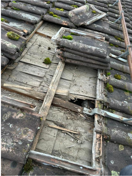
Defektes Unterdach
